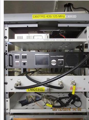
Geplant war, den 70cm Einstieg auf 431,525 MHz um einen Zugang mit C4FM Digital-Technologie zu erweitern. Hierzu würde die bestehende Hardware am Standort demontiert und durch einen geeigneten C4FM Repeater ersetzt werden. Der Vorschlag erhielt die Zustimmung der Anwesenden Mitglieder und Wolfgang, DG2MEL machte sich auf die Suche nach günstigen Einkaufsquellen. Nachdem die erforderliche Hardware geordert und schließlich geliefert wurde,
